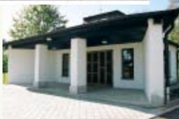
Dom smútku – v súčasnosti v rekonštrukcii Trauerhaus - zur Zeit in Renovierung A cemetery house – currently under reconstruction
