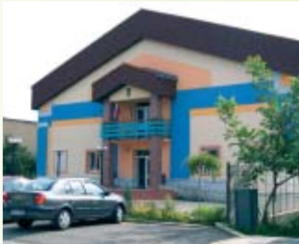
Obecný úrad po rekonštrukcii a prístavbe kongresovej sály • Gemeindeamt nach der Renovierung und dem Anbau der Kongreßhalle • The Municipal Office after the reconstruction and the addition of a congress hall
